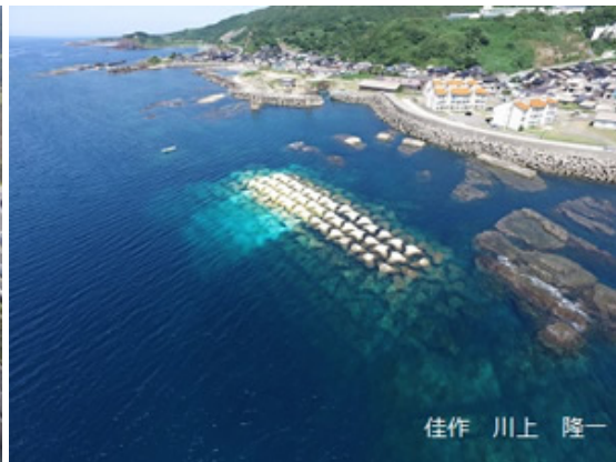
地域・自然を守る離岸堤
